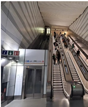
Elevador inclinado na estação de Liverpool Street, Londres
