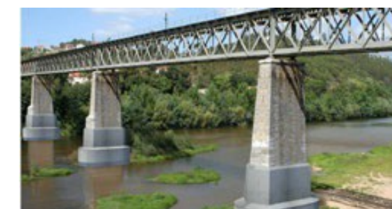
13 pontes e pontões
